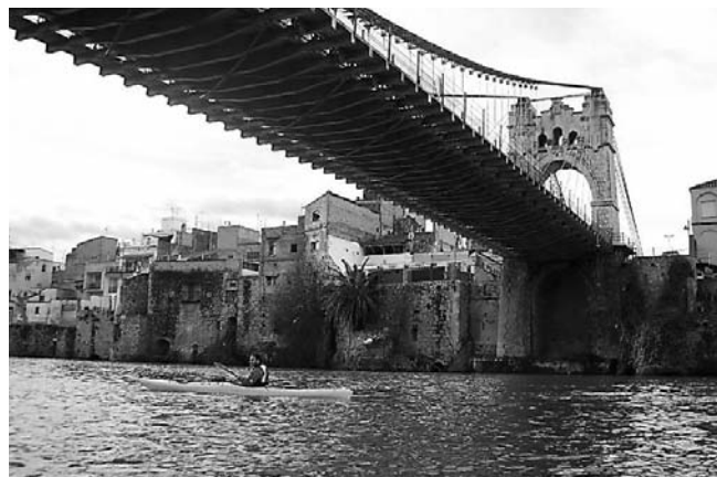
Pont Penjant d'Amposta.
