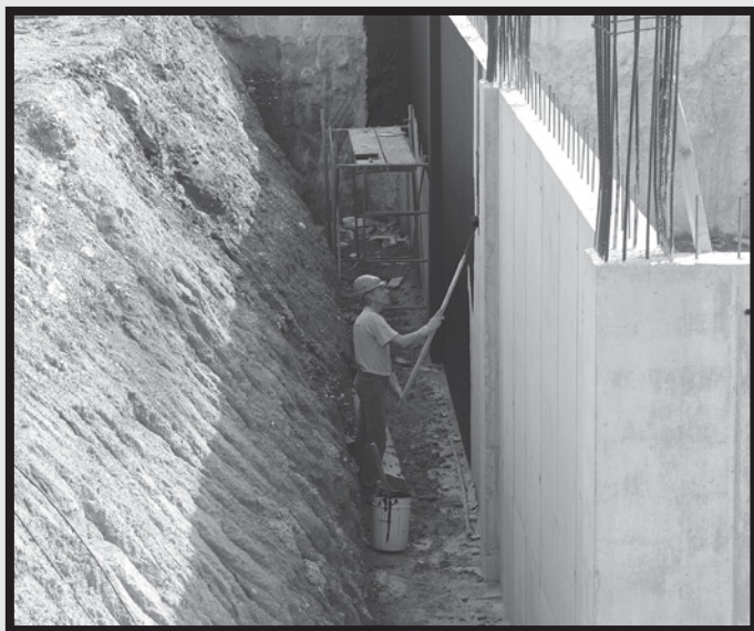
Ja s'han aixecat els murs de contenció de la planta soterrada de la nova seu del Club.
