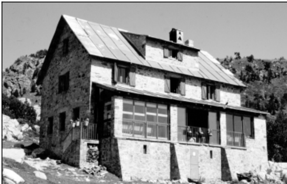
Refugi d'Ulldeter (2.220 m), situat prop del naixement del Ter i a la comarca del Ripollès. Foto de Jordi Gironès.
