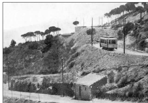
El tramvia de Vallvidrera baixant pel camí de Vallvidrera a Barcelona.
